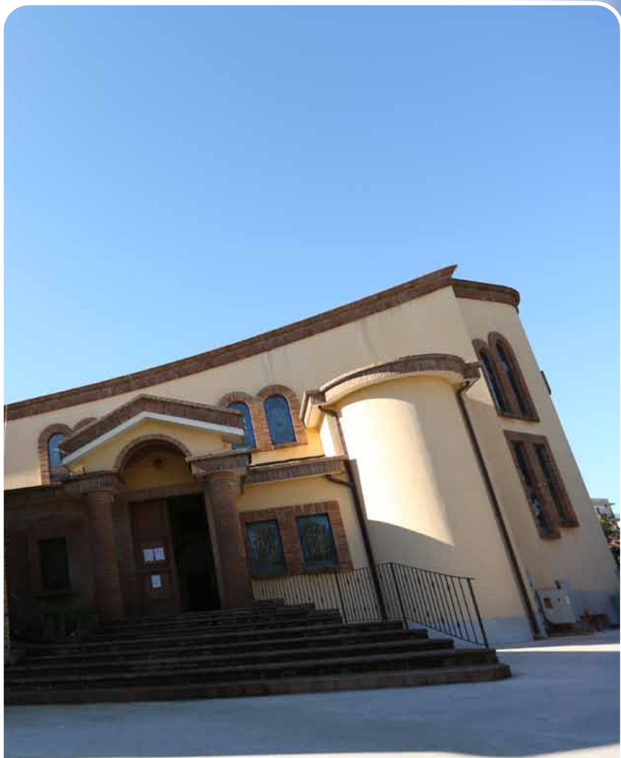
Sant'Ilario dello Ionio - Facciata della nuova Chiesa del Sacro Cuore di Gesù
