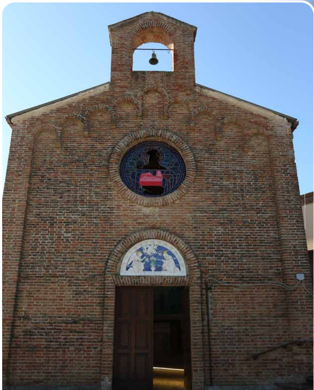
Sant'Ilario dello Ionio - Facciata principale della Chiesetta del Sacro Cuore di Gesù
